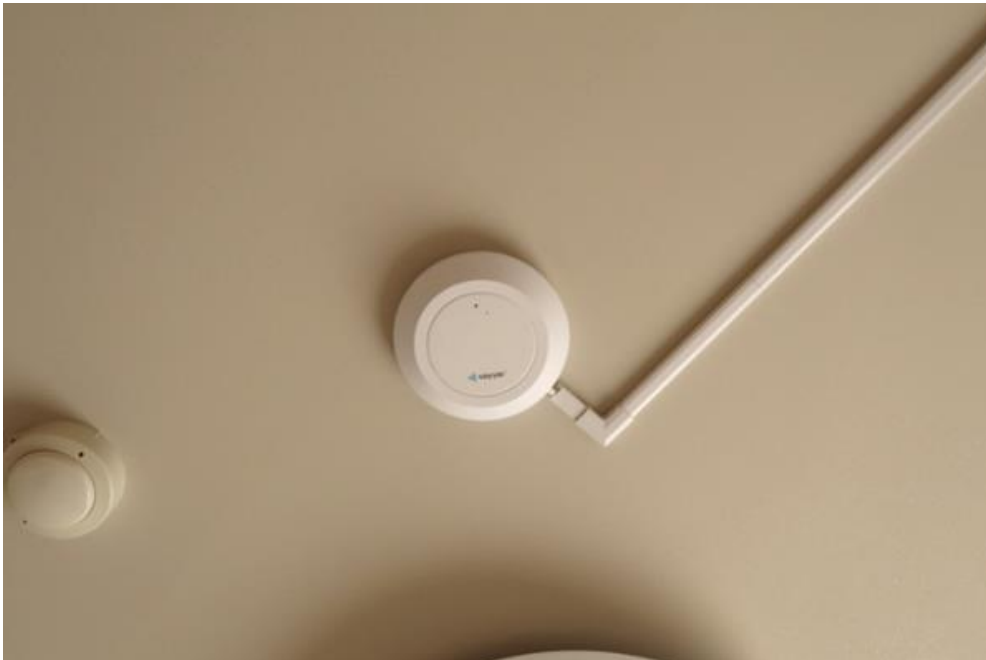
（図）介護施設での実証のため天井に設置した転倒検知センサー
